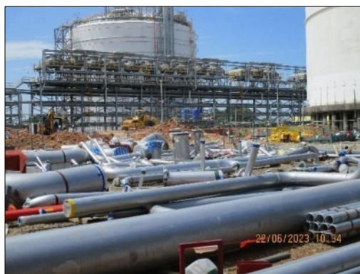
รูปที่ 2-53 การพ่นทรายทาสีท่อมาจากโรงงานของผู้ผลิต เพื่อลดการเกิดของเสียที่หน้างาน
