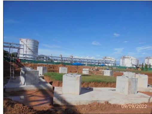
รูปที่ 2-49 การก่อสร้างฐานรากแผ่ (Spread Footing)
