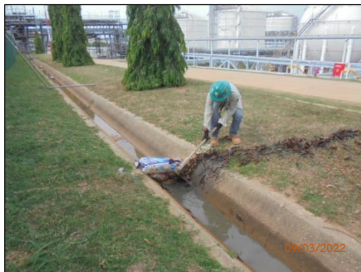
รูปที่ 2-50 การกันกระสอบทรายป้องกันเศษดินไม่ให้ชะลงสู่ระบบระบายน้ำของโครงการ
